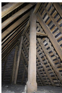
Charpente de comble, partie haute, vue depuis le sud
